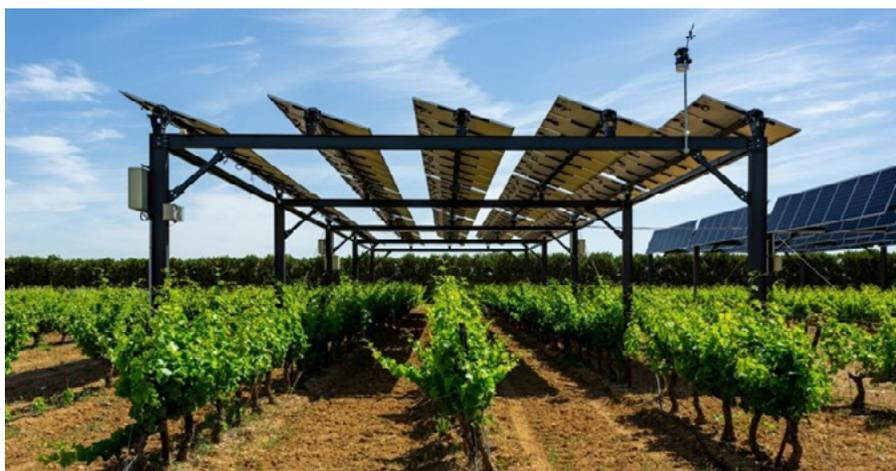
**Figura 3.** Soportes fijos al terreno que permiten colocarlos paneles a determinada altura.
