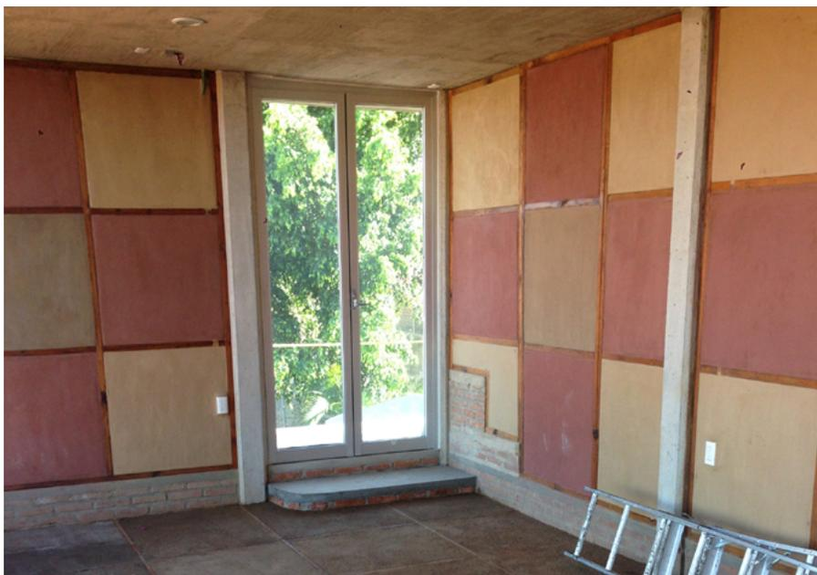
**Figura 12.** Estructura de concreto armado rellena con muros de tierra entramada en el CEDE-IMDEC, Guadalajara, Jalisco.
