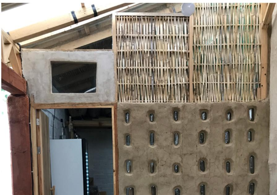
**Figura 10.** Paneles parcialmente cubiertos con barro para permitir la vista del entramado en la parte superior. Se insertaron botellas como recurso estético y de iluminación en la zona baja. Panadería Dulce Peligro, San Agustín Etla, Oaxaca.
