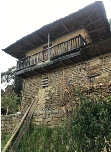
**Figura 6.** El agrietamiento es la manifestación de la fuerza y actividad de las arcillas que permiten que la tierra se adhiera al entramado de madera. Cojitambo, Ecuador.
