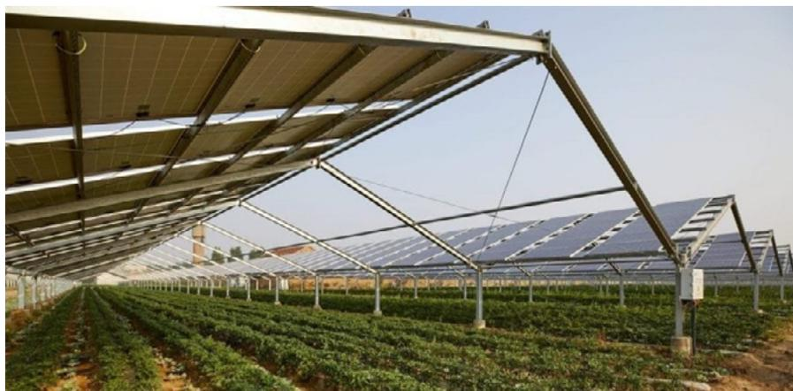
**Figura 4.** Estructuras compuestas de gran altura con paneles fotovoltaicos sobre cultivos.
