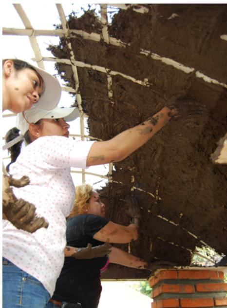
**Figura 9.** Aplicación de la capa de lodo a una bóveda tipo domocaña realizado en un taller práctico en la Universidad de Colima en Coquimatlán.
