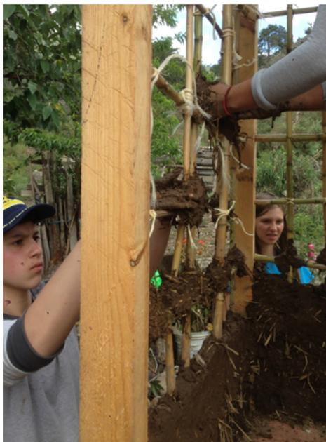
**Figura 7.** Estructura con entramado cuadrículado para un baño seco realizado en un taller infantil en Zautla, Puebla.
